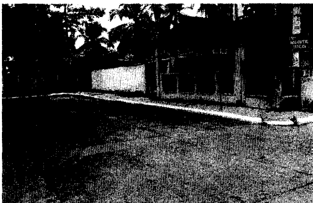
Foto No. 7, Tramo Puerto Iztapa, falta bacheo.
