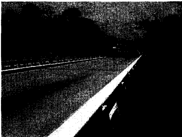
■ Puente San Juan (Guatemala)
