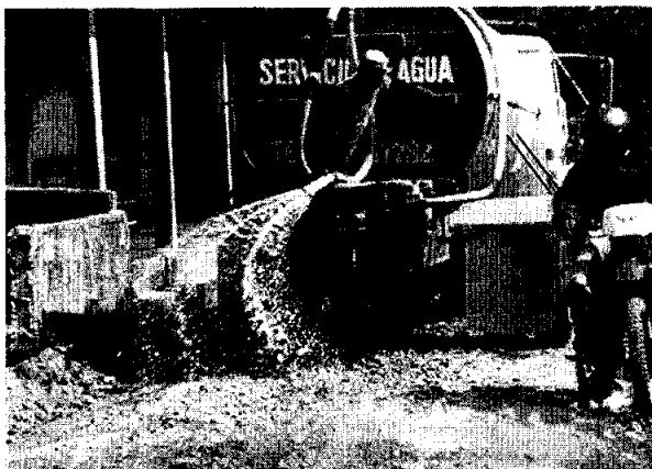
Fotografía No. 3 En el tramo San Rafael Independencia – Bifurcación Villa Linda se observa que la cisterna de agua en labor de irrigación.
