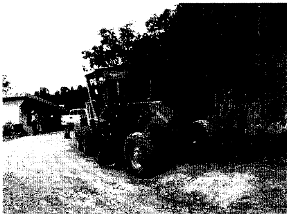
Fotografía No. 4 En el tramo San Rafael Independencia – Bifurcación Villa Linda, se observa la motoniveladora que se utiliza para la conformación.
