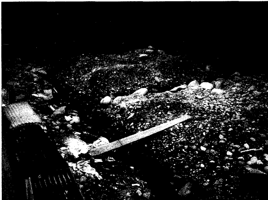
Otra vista de cimentación Ampliación de Centro Escolar, cantón, Ixtalito
