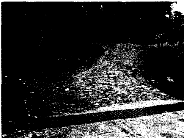
FOTO No. 7: FINAL DEL PROYECTO. VISTA HACIA ATRÁS, TRAMO EMPEDRADO.
