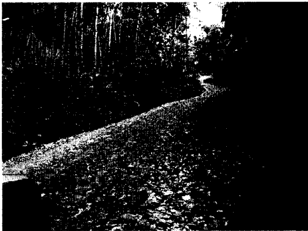
FOTO No. 4: TRAMO EMPEDRADO DEL PROYECTO. VISTA HACIA ADELANTE.
