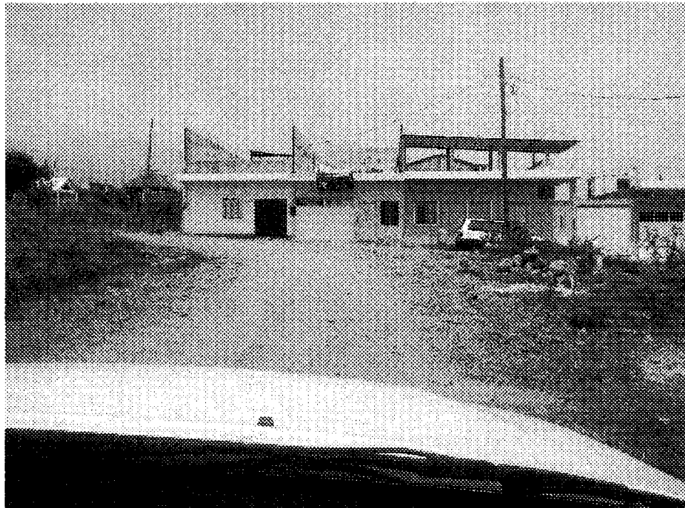
Esta fotografía muestra una vista de otro tramo del camino a pavimentar.
