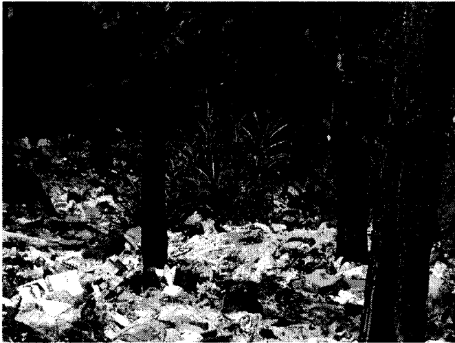
FOTO No. 7: ACERCAMIENTO DE LA FOTO No. 5 DEL MATERIAL DERRAMADO DEL TANQUE DE LODOS USADO EN LA PERFORACIÓN DEL POZO, DESFOGADO SOBRE LA SUPERFICIE DEL BARRANCO DEL BASURERO, QUE LLEGA HASTA EL FONDO DEL MISMO.
