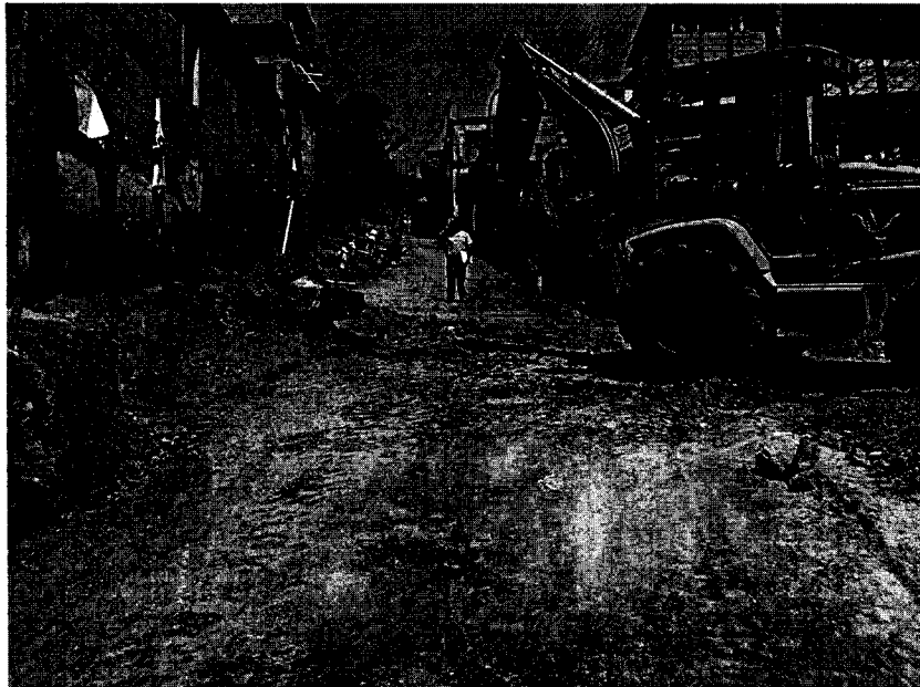
Una segunda vista de la calle a pavimentar, donde se realizan trabajos de excavación para las cunetas.
