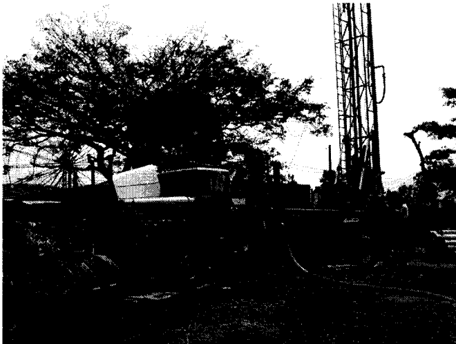
FOTO No. 2: ACERCAMIENTO DE LA TORRE PERFORADORA DEL POZO.
