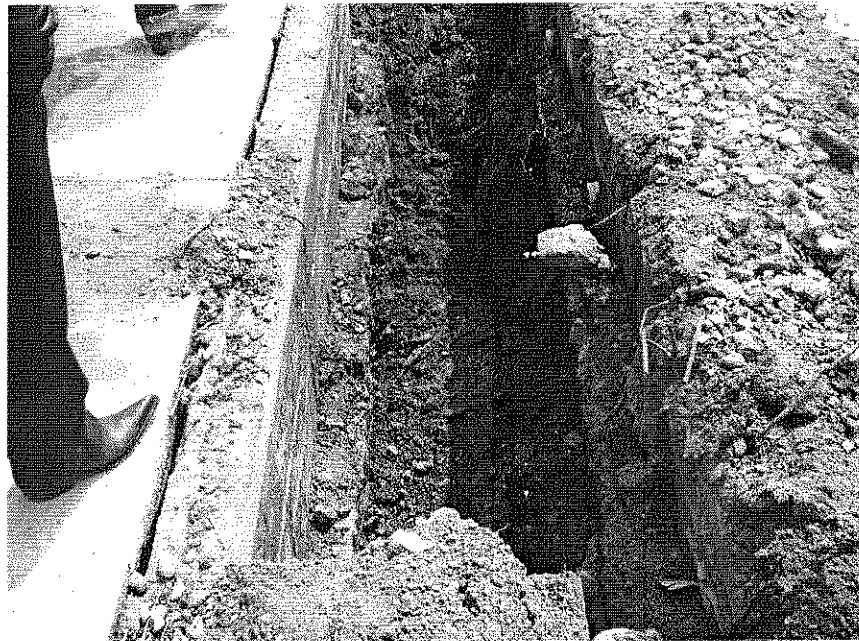
Vista de zanjeo en el lugar
