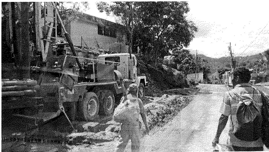
Material extraído de la perforación del pozo
