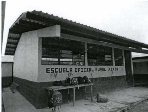
3 Aula escolar, Aldea San Rafael El Arado, Sumpango, Sac.
