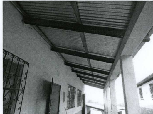
2 Techado escolar, Aldea San José El Yalú, Sumpango, Sac.
