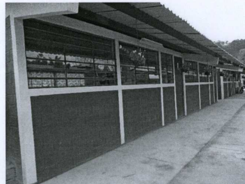
10 Aulas escolares y sanitarios, Escuela Of. Rural Mixta, Aldea San Felipe de Jesús, Antigua Guatemala, Sac.
