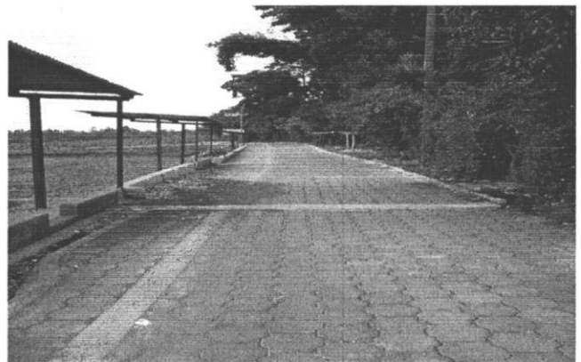
4 Pavimentación, sector El Campo, Aldea Colmenas, Villa Canales
